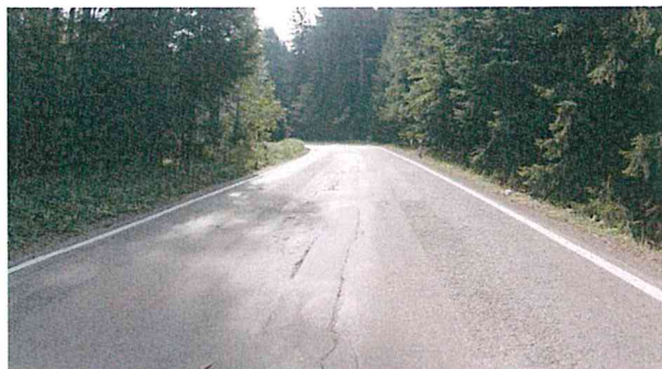
Pohled na úsek (podélné a mozaikové trhliny)
