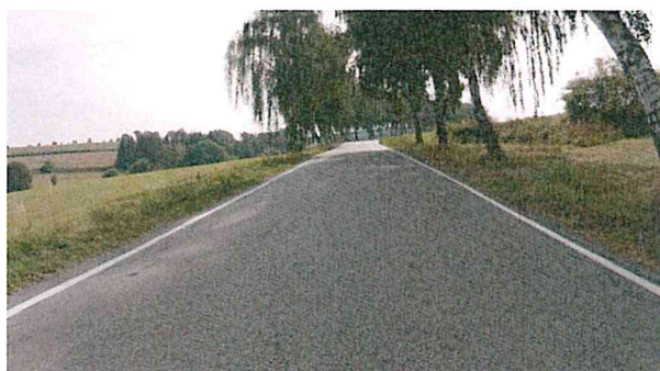
Pohled na úsek (pokles okraje vozovky, trhliny)
