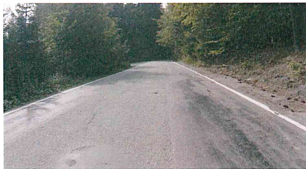
Pohled na úsek (podélné trhliny, vysprávkky okraje)
