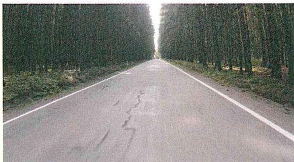
Pohled na úsek (podélné a mozaikové trhliny)
