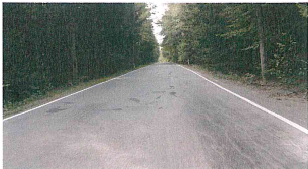
Pohled na úsek (mozaikové trhliny, pokles v jízdní stopě)
