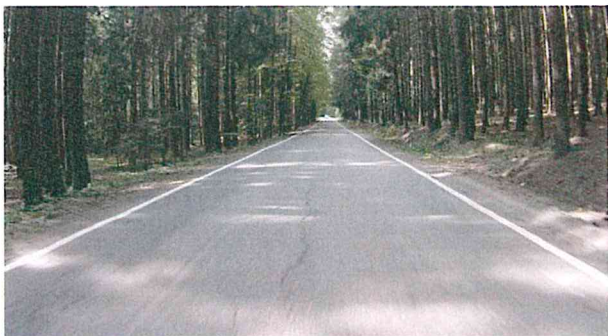
Pohled na úsek (podélné trhliny, poruchy okraje)
