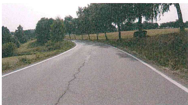
Pohled na úsek (podélná trhlina)
