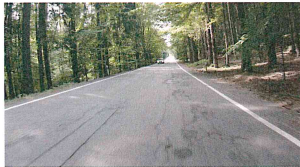
Pohled na úsek (výtluky, mozaikové trhliny, vysprávkky)
